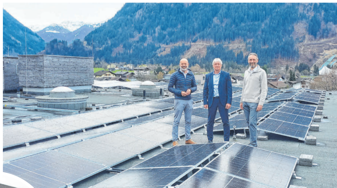
Bürgermeister Jürgen Kuster, Uwe Lindner, Verwaltungsdirektor der Reha-Klinik, und Christoph Walla, Geschäftsführer der ENGIE Energie GmbH, freuen sich über die neue Photovoltaik-Anlage der Klinik.
